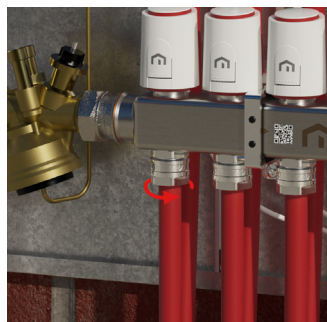
Hydraulische Installation der Verrohrung sowie Prüfung aller Verbindungen und Verschraubungen
