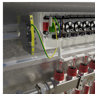
Elektrischer Anschluss und Einstellung der Klemmleiste
